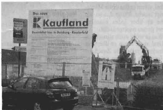
Die Bauarbeiten für Kaufland haben begonnen. Die Bagger rollen und ein Schild ist aufgestellt.
